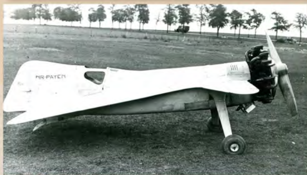
Le Pa.101 à ses débuts, avec moteur non capoté.
